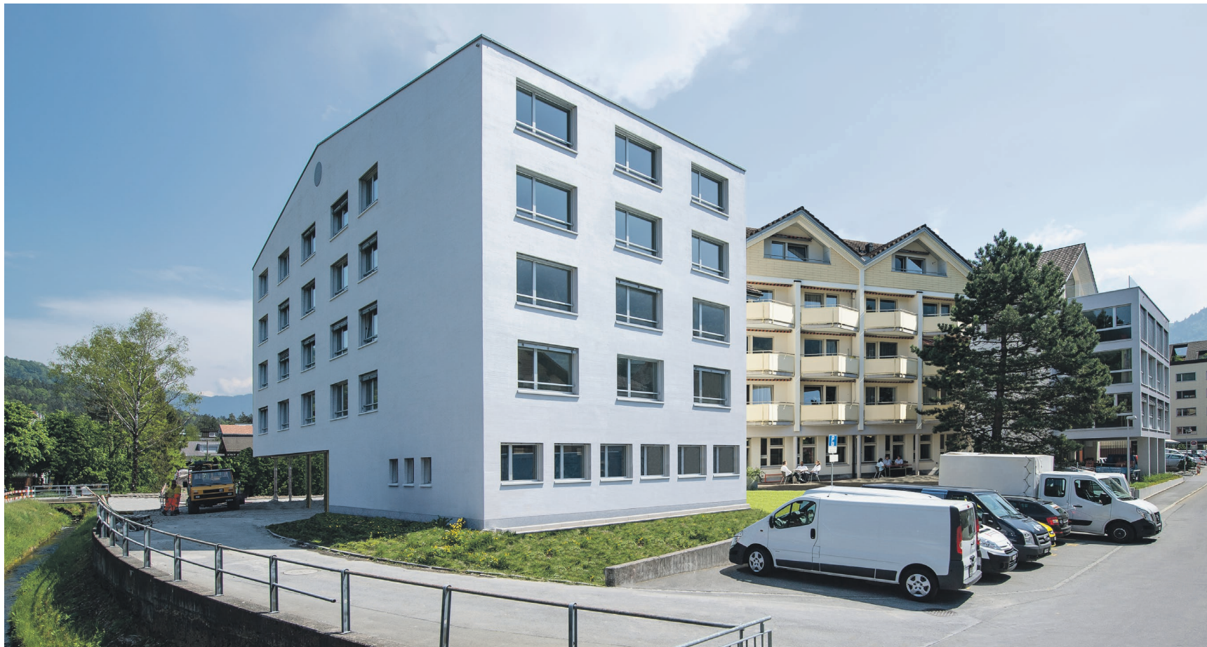
Der fertiggestellte Anbau Nord fügt sich harmonisch in den bestehenden Bau ein.
