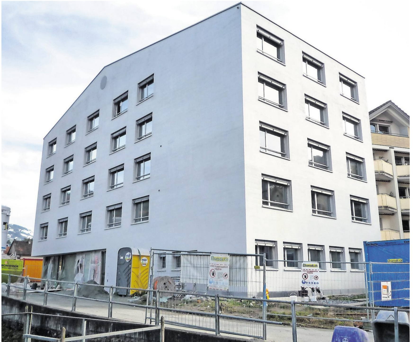
So sieht der Neubau kurz vor der Vollendung aus, daneben der sanierte Altbau.
