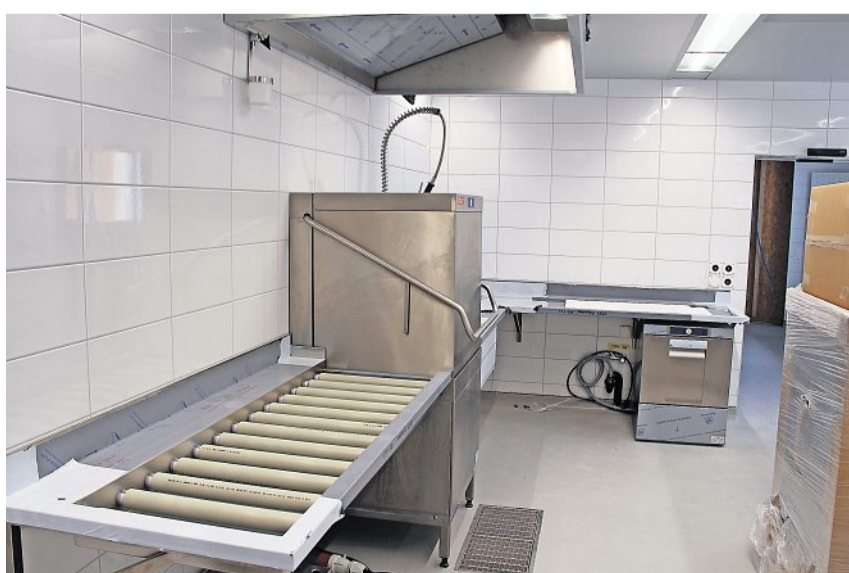
Die Küche im AZM wird ebenfalls totalsaniert.
