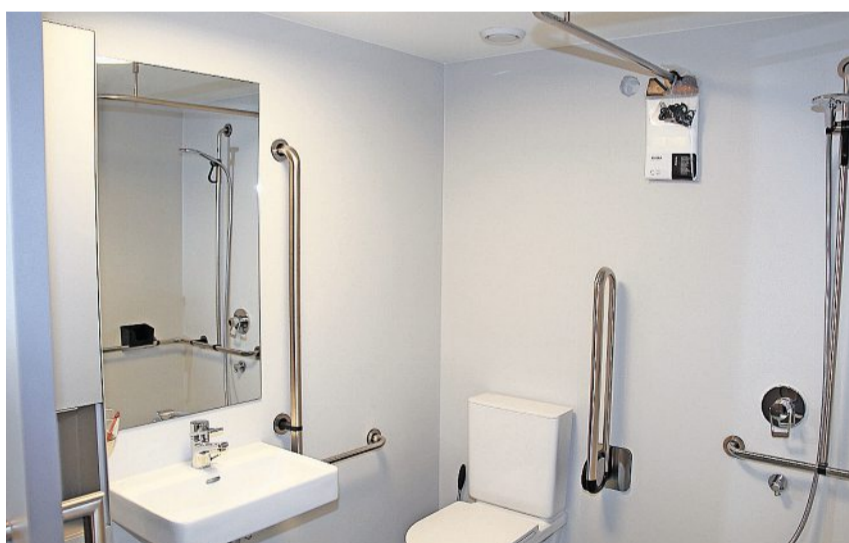
In den Nasszellen ist der Innenausbau nach heutigen Standards ausgeführt worden.
