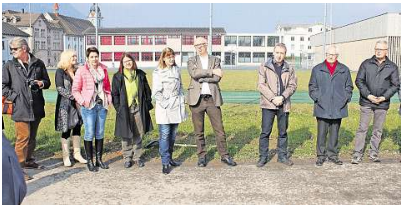
Gemeindepräsident und verschiedene Behördenmitglieder waren ebenfalls am Spatenstich zugegen.
