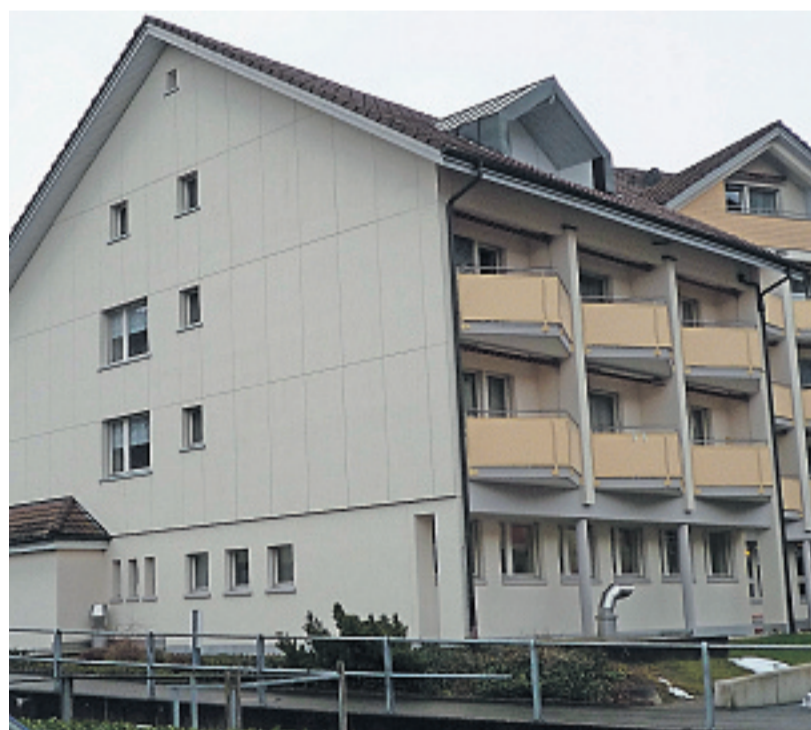
Die Nordseite des Altersheims, hier soll der Anbau realisiert werden. Bild Oberholzer Guido Architekten AG
